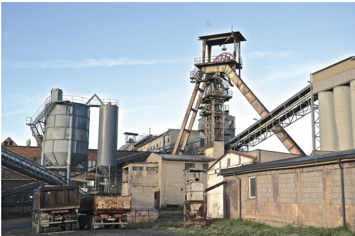
Novodobě obestavěná těžní věž JOM při pohledu od dekontaminační stanice.
