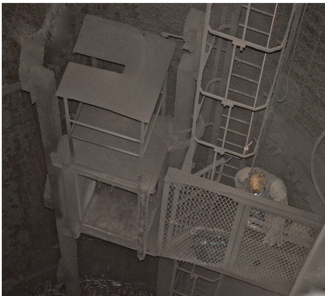
NJJ – stvol jámy několik metrů nad vodou v hloubce cca 15 m. Vlevo pomocná klec pro mužstvo, vpravo lezný oddělení.
