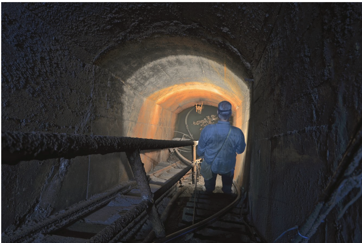
ÚJ – stvol úpadnice několik metrů nad vodou. Z ÚJ se čerpala voda na dekontaminaci. Vlevo kolejová dráha, vpravo betonové schodiště.
