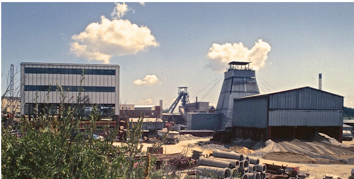
NJJ v popředí a JOM v pozadí. Foto z internetu z poloviny 80. let, kdy se hloubila NJJ. Vpravo vepředu betonárka pro betonáž výztuže NJJ.
